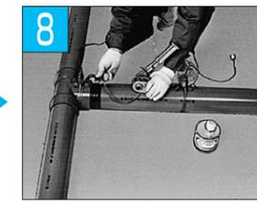
接着剤塗布後、挿入機のワイヤー側フックは継手固定具に、挿入機側のフックはパイプ側固定具にセットします。
