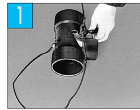
DT受口に固定具をあてます。締付けワイヤーは玉掛側を引き出しておきます。
