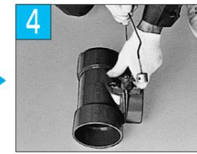
アルミコマ側のワイヤーを強く引張り、固定具を十分締付けたあと、蝶ナットを締付け、ワイヤーを固定します。
