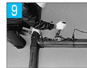
すばやく、挿入機のレバーを操作して接合します。接合後はすぐに取外さず、しばらく保持してください。
