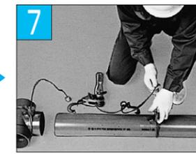
もうひとつの固定具を同様の手順でパイプに取付け、固定具を管軸方向に引張り、滑らないことを確認してください。(固定具の取付は管端から30~40cmの位置)
