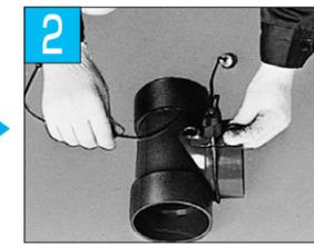
固定具をワイヤーで二重に巻きつけます。ワイヤーは継手受口の段差部にかかるように巻きつけます。
